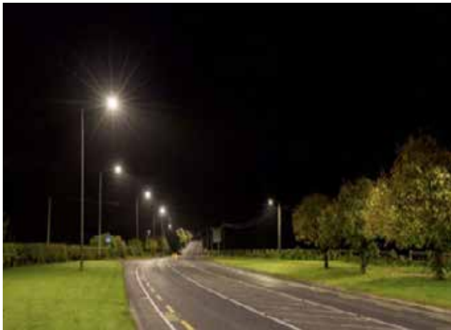
Laghdóidh an Tionscadal um Éifeachtúlacht Fuinnimh Soilsithe Poiblí úsáid fuinnimh i soilsíú poiblí faoi 70% ar a laghad.
