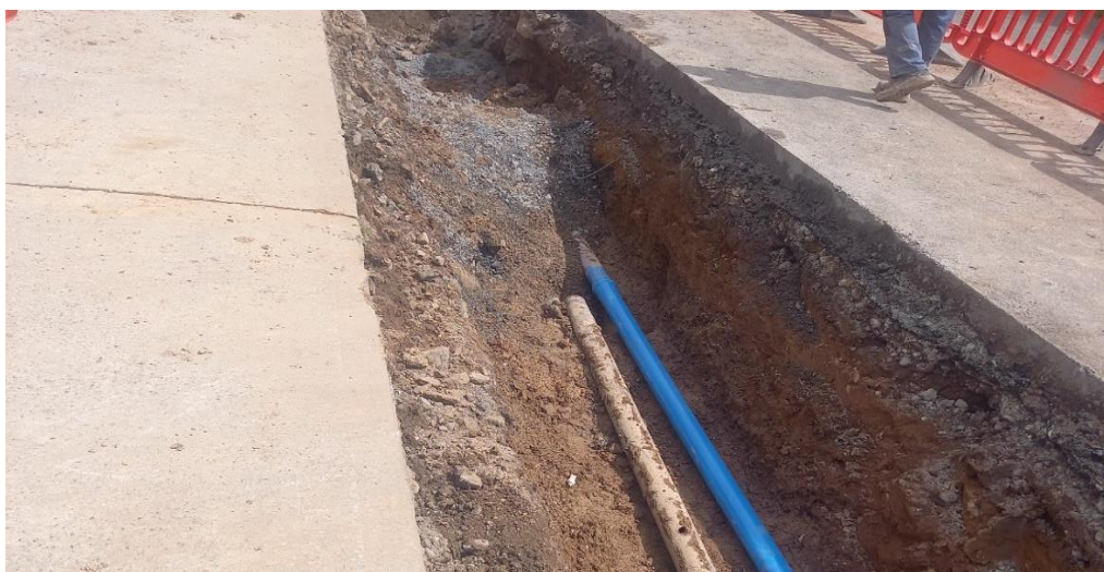
Príomhphíobán nua uisce a dhruileáil ag Sráidbhaile an tSléibhe Rua
