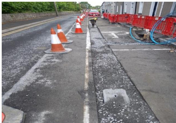
Aistriú seirbhísí chuig príomhphíobán nua HDPE, ar thaobh an phobail, ar Shráid Mhichíl, Cathair Chill Chainnigh.
