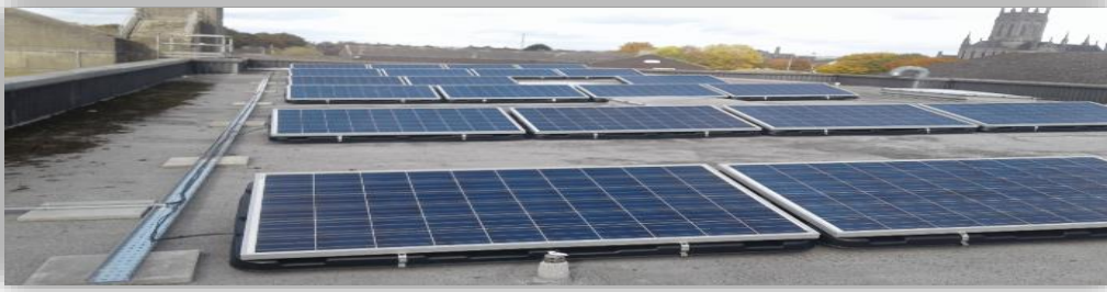
Painéil fhótavoltacha 6kWp i Stáisiún Dóiteán Chill Chainnigh
